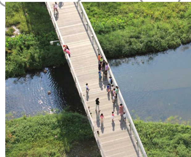
Vom zentralen Traversesteg mit Rundumblick kann die Kernzone erlebt werden, ohne Böden, Flora und Fauna zu beeinträchtigen. Gleichzeitig gewährt er – inmitten grüner Oase – Aussicht auf das Alpenpanorama.
